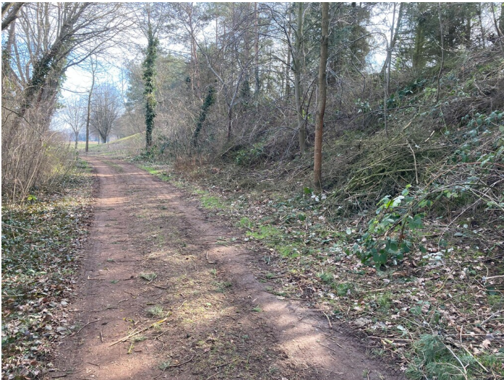
Lärmschutzdamm Siebanlage Sabrodt Fotograf/Urheber: Nora Wiedemann
