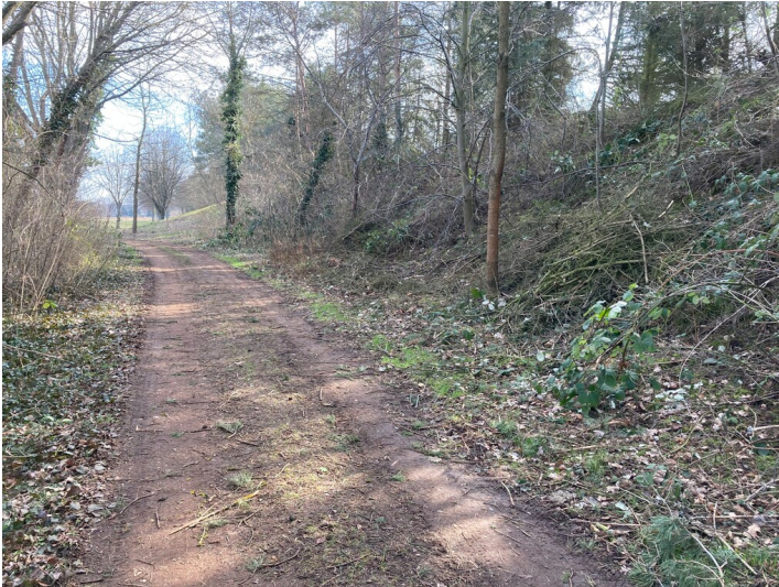
Lärmschutzdamm Siebanlage Sabrodt Fotograf/Urheber: Nora Wiedemann
