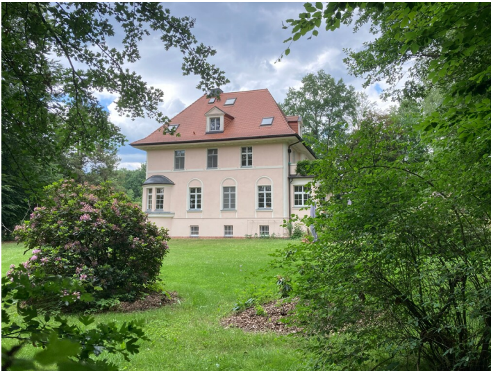
Direktorenvilla der Werksiedlung Heide in Wiednitz Fotograf/Urheber: Nora Wiedemann
