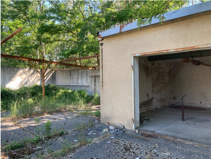
Betriebsgebäude der Brikettfabrik Fotograf/Urheber: Nora Wiedemann
