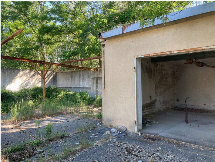
Betriebsgebäude der Brikettfabrik Fotograf/Urheber: Nora Wiedemann
