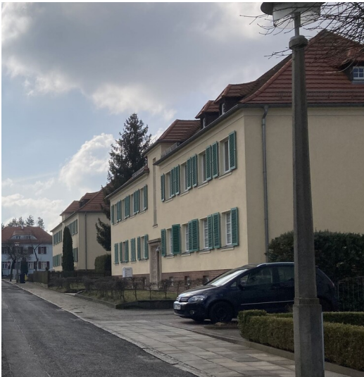
Wohnhaus der Werksiedlung Lauta-Nord Fotograf/Urheber: Nora Wiedemann
