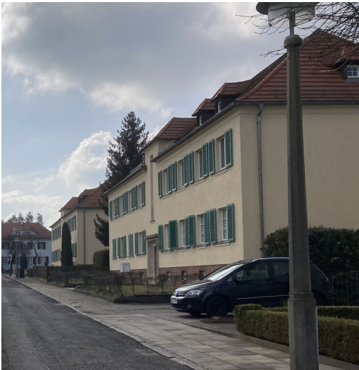
Wohnhaus der Werksiedlung Lauta-Nord Fotograf/Urheber: Nora Wiedemann
