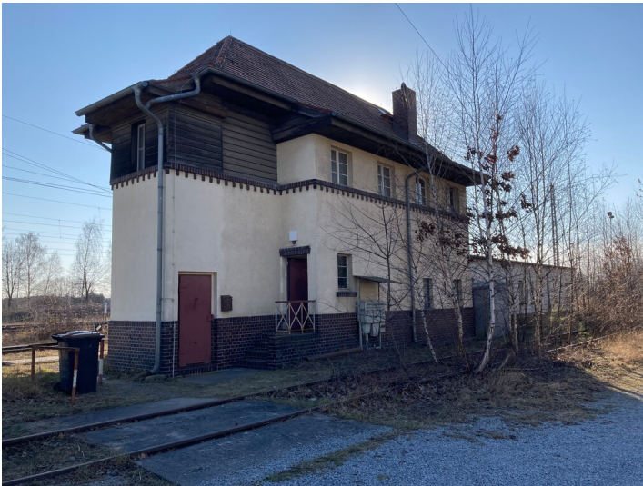
Stellwerk Fotograf/Urheber: Nora Wiedemann
