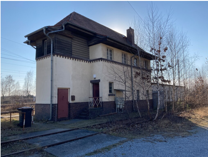
Stellwerk Fotograf/Urheber: Nora Wiedemann
