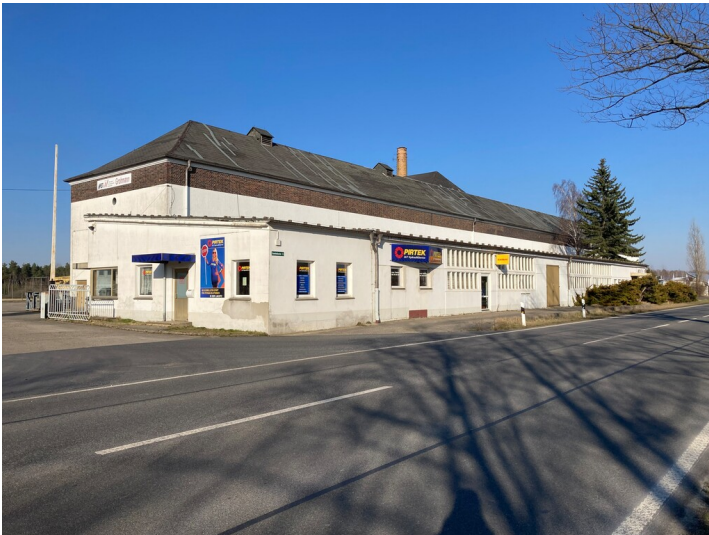
Reparaturwerkstatt Fotograf/Urheber: Nora Wiedemann
