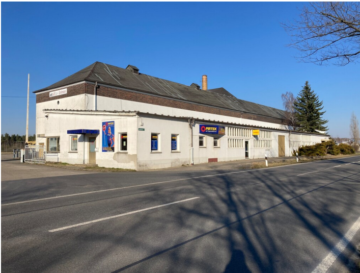
Reparaturwerkstatt Fotograf/Urheber: Nora Wiedemann
