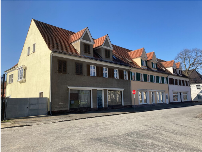
Wohn- und Geschäftshäuser Am Markt 3, 4 und 5 der Kolonie Erika Fotograf/Urheber: Nora Wiedemann
