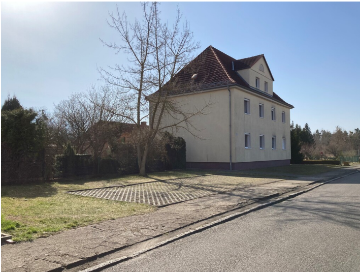
Wohnhaus Oststraße 8 der Kolonie Erika Fotograf/Urheber: Nora Wiedemann
