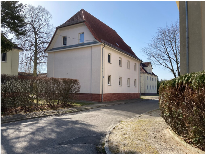
Wohnhaus Oststraße 7 der Kolonie Erika Fotograf/Urheber: Nora Wiedemann
