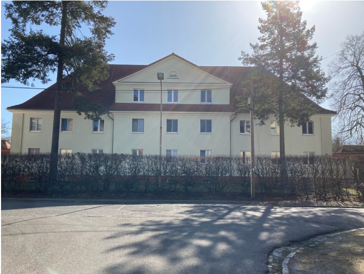
Wohnhaus Oststraße 6 der Kolonie Erika Fotograf/Urheber: Nora Wiedemann
