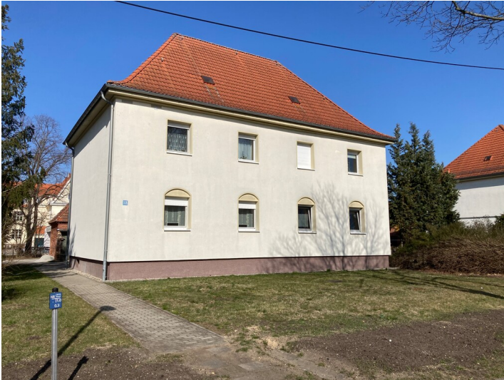
Wohnhaus Oststraße 12 der Kolonie Erika Fotograf/Urheber: Nora Wiedemann
