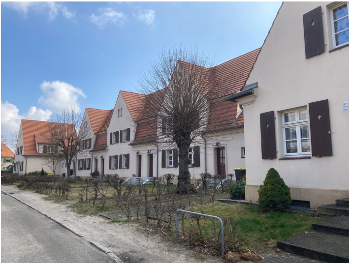
Teil der Objektgruppe Gartenstadtsiedlung Lauta Nord (30800141): eingeschossiges Arbeiterwohnhaus Fotograf/Urheber: Nora Wiedemann
