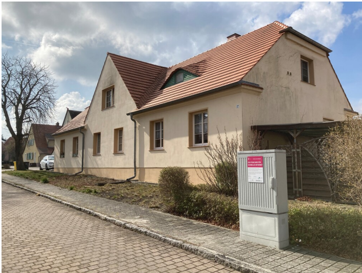
Teil der Objektgruppe Gartenstadtsiedlung Lauta Nord (30800141): Arbeiterwohnhaus Fotograf/Urheber: Nora Wiedemann
