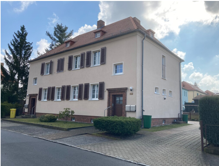
Teil der Objektgruppe Gartenstadtsiedlung Lauta Nord: Arbeiterwohnhaus Fotograf/Urheber: Nora Wiedemann
