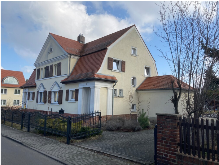
Beamtenwohnhaus, Teil der Objektgruppe Gartenstadt Lauta-Nord Fotograf/Urheber: Nora Wiedemann
