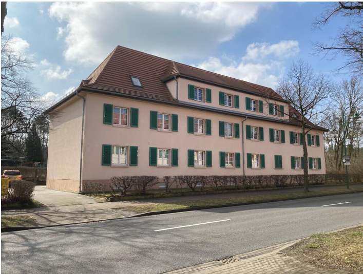
Mehrfamilienwohnhaus der Gartenstadt Lauta-Nord Fotograf/Urheber: Nora Wiedemann
