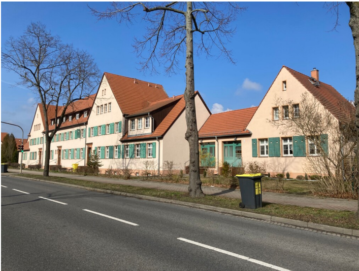
Mehrfamilienhaus Gartenstadt Lauta-Nord, Straße der Freundschaft Fotograf/Urheber: Nora Wiedemann
