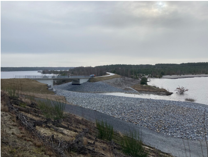
Blunodamm mit Blick Richtung Süden (Bergen) Fotograf/Urheber: Nora Wiedemann
