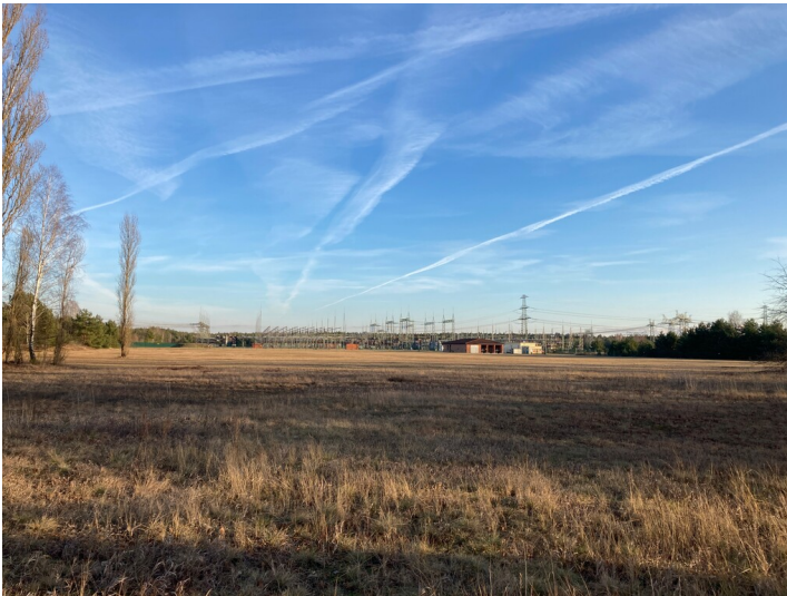
Umspannwerk Graustein 380 kV Fotograf/Urheber: Nora Wiedemann
