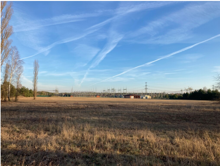
Umspannwerk Graustein 380 kV Fotograf/Urheber: Nora Wiedemann
