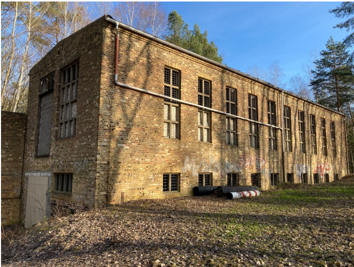
Transformatorstation Fotograf/Urheber: Nora Wiedemann
