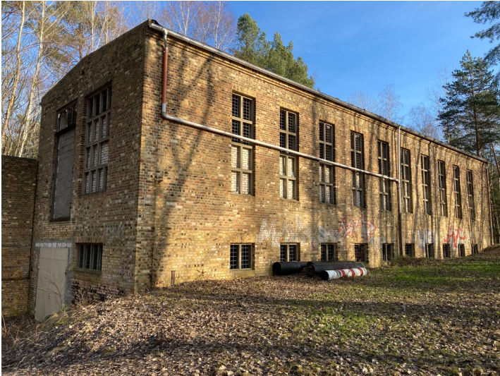
Transformatorstation Fotograf/Urheber: Nora Wiedemann
