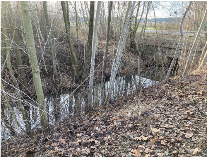
Umverlegte Struga Fotograf/Urheber: Nora Wiedemann
