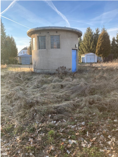
Abwasserpumpstation der Glückaus-Siedlung Schleife Fotograf/Urheber: Nora Wiedemann
