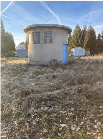
Abwasserpumpstation der Glückaus-Siedlung Schleife Fotograf/Urheber: Nora Wiedemann
