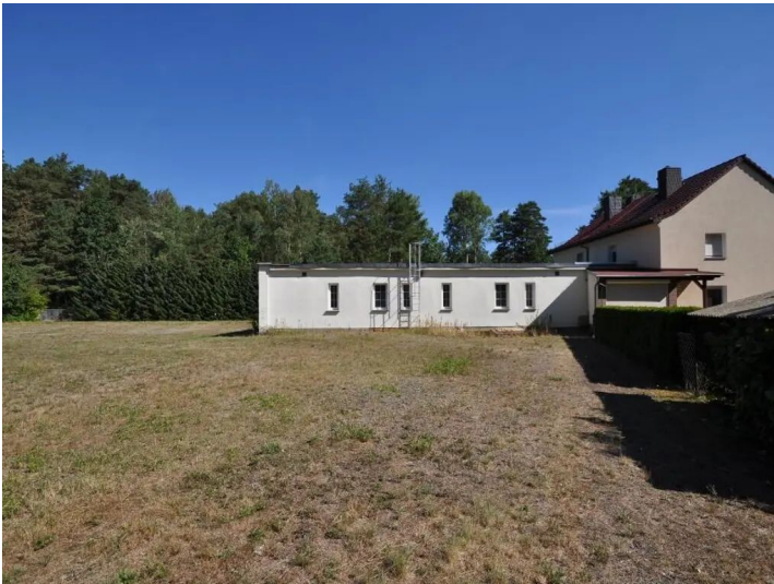
Wasserwerk Schleife Fotograf/Urheber: Nora Wiedemann
