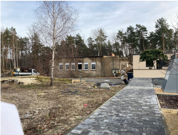
Tagesanlagen des ehemaligen Tagebaus "Trebendorfer Felder" Fotograf/Urheber: Nora Wiedemann
