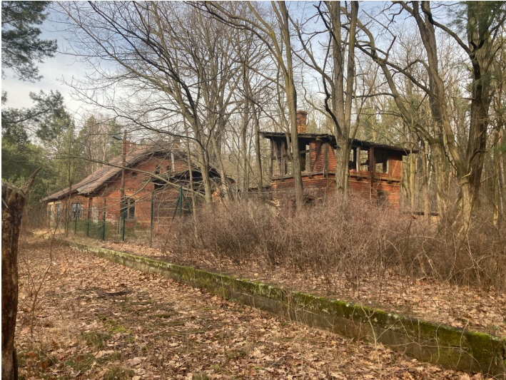
Bahnhofsgebäude und Toilettenhäuschen am Tagebau "Trebendorfer Felder" Fotograf/Urheber: Nora Wiedemann
