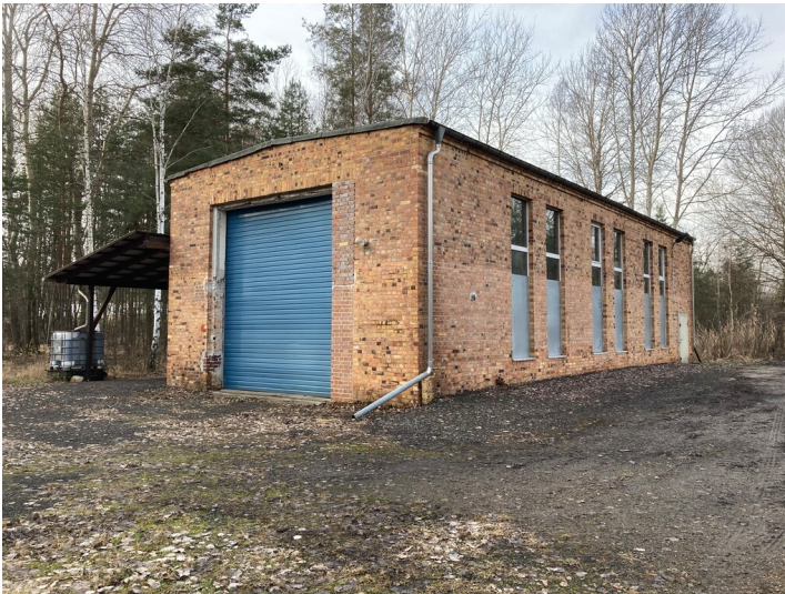
Lokschuppen des Tagebaus Trebendorfer Felder Fotograf/Urheber: Nora Wiedemann
