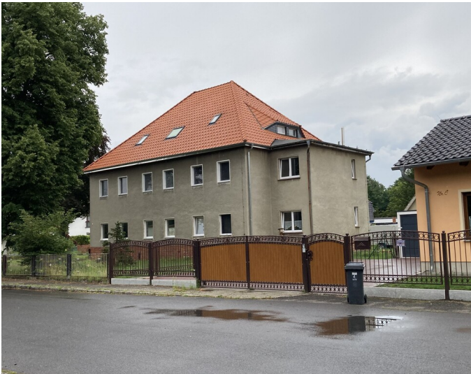
Rentnerhaus der Werkssiedlung Werminghoff in Knappenrode Fotograf/Urheber: Nora Wiedemann
