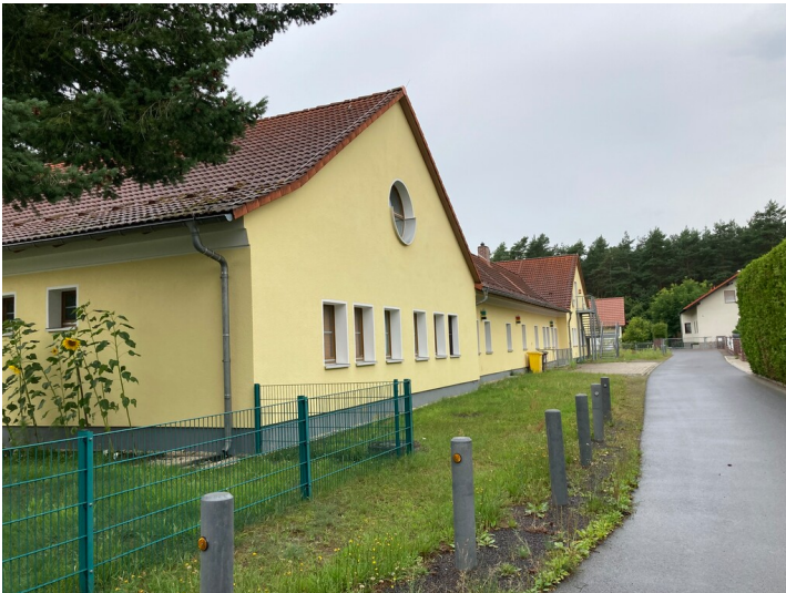
Kindergarten ""Wirbelwind"" der Werksiedlung in Knappenrode Fotograf/Urheber: Nora Wiedemann
