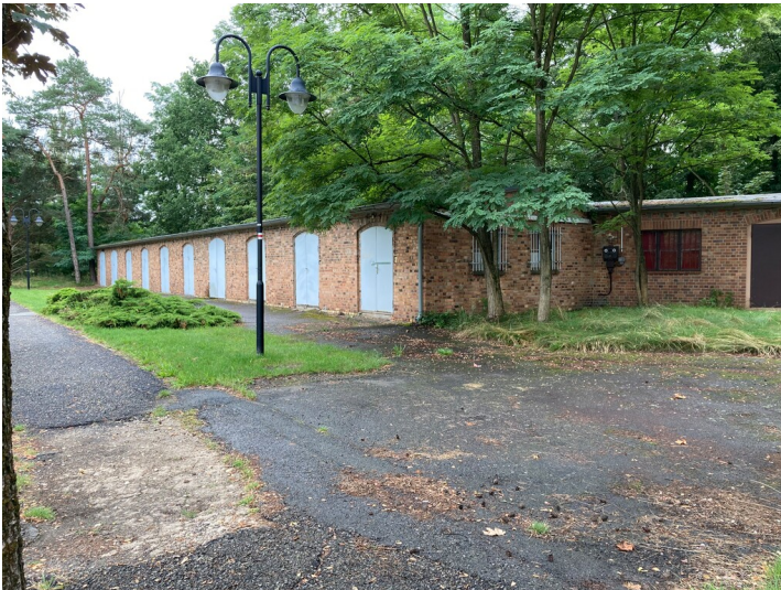
Unterstellgebäude der Brikettfabrik Werminghoff Fotograf/Urheber: Nora Wiedemann
