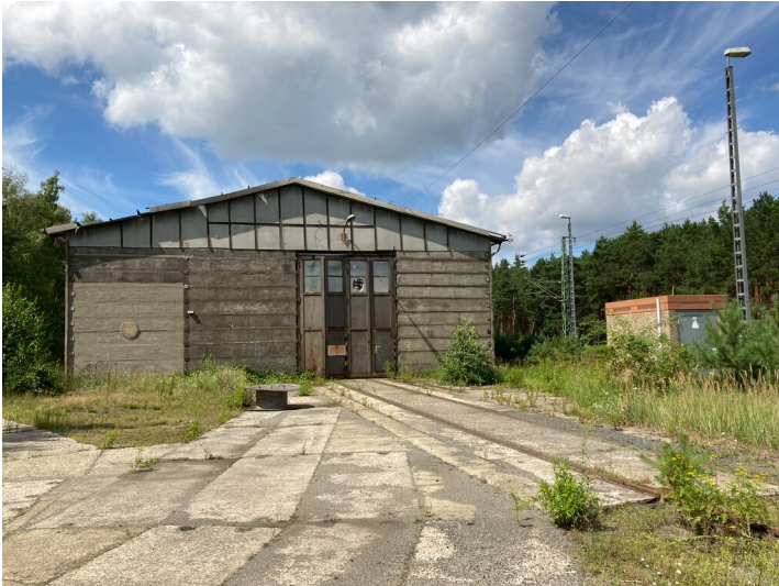
Halle der Bahnbrückenmeisterei Fotograf/Urheber: Nora Wiedemann
