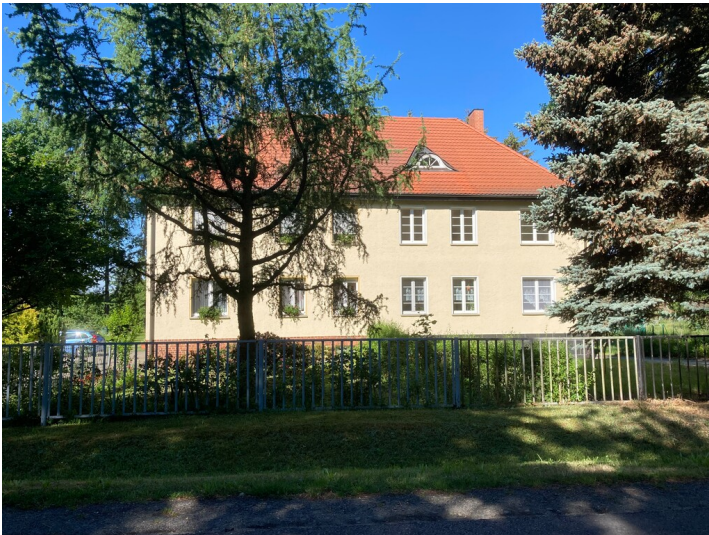
Zwei Beamtenwohnhäuser der Heye-Braunkohlewerke in Wiednitz/Heide Fotograf/Urheber: Nora Wiedemann
