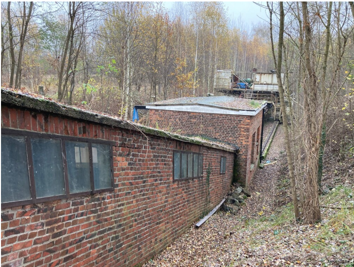
Schrägbandfördereinrichtung des Grabenbunkers zum Hochbunker Fotograf/Urheber: Nora Wiedemann
