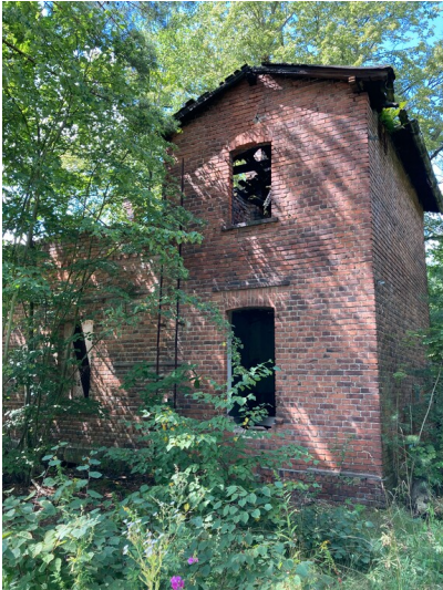
Bahnwärterhaus Bahnhof Knappenrode Fotograf/Urheber: Nora Wiedemann
