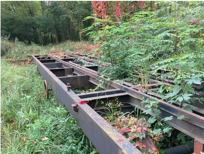
Überladerampe der Brikettfabrik Werminghoff in Knappenrode Fotograf/Urheber: Tom Pfefferkorn
