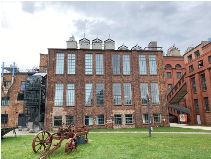
Kühlhaus IV der Brikettfabrik Werminghoff in Knappenrode Fotograf/Urheber: Nora Wiedemann
