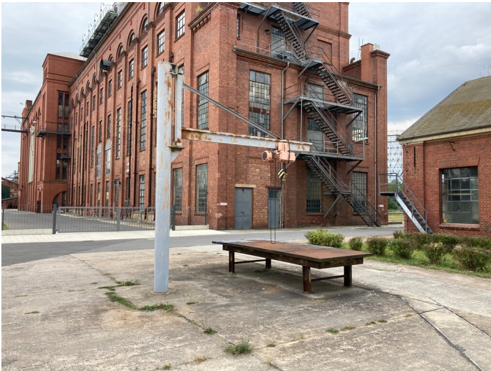
Galgenkran auf dem Gelände der Brikettfabrik Werminghoff in Knappenrode Fotograf/Urheber: Nora Wiedemann
