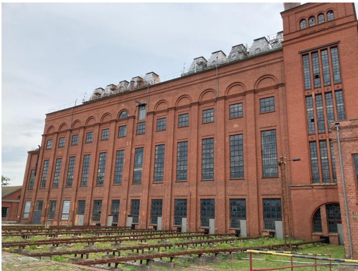
Fabrik II mit Kühlsträngen Fotograf/Urheber: Kathrin Krüner
