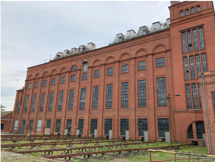
Fabrik II mit Kühlsträngen Fotograf/Urheber: Kathrin Krüner
