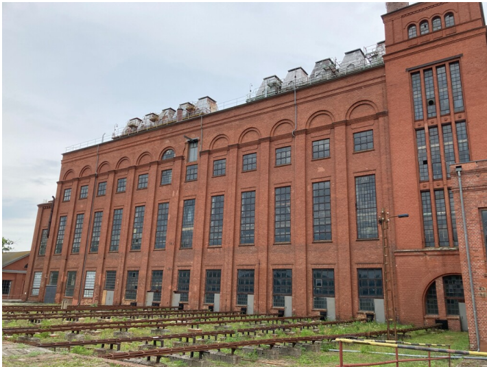
Fabrik II mit Kühlsträngen Fotograf/Urheber: Kathrin Krüner
