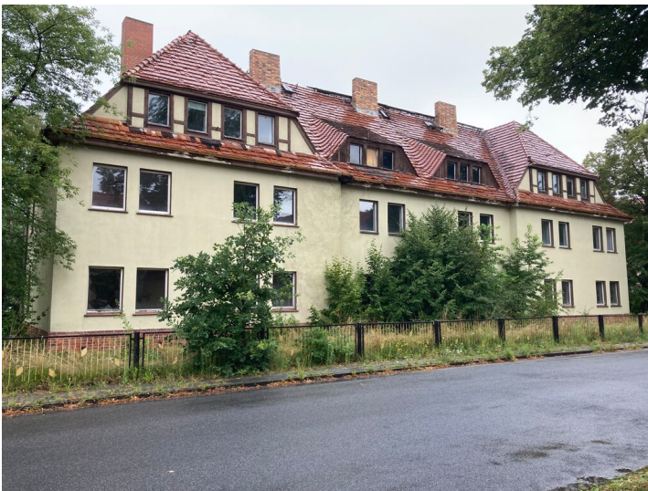
Mehrfamilienhaus der Werkssiedlung Werminghoff, Lessingstraße 17 in Knappenrode Fotograf/Urheber: Nora Wiedemann
