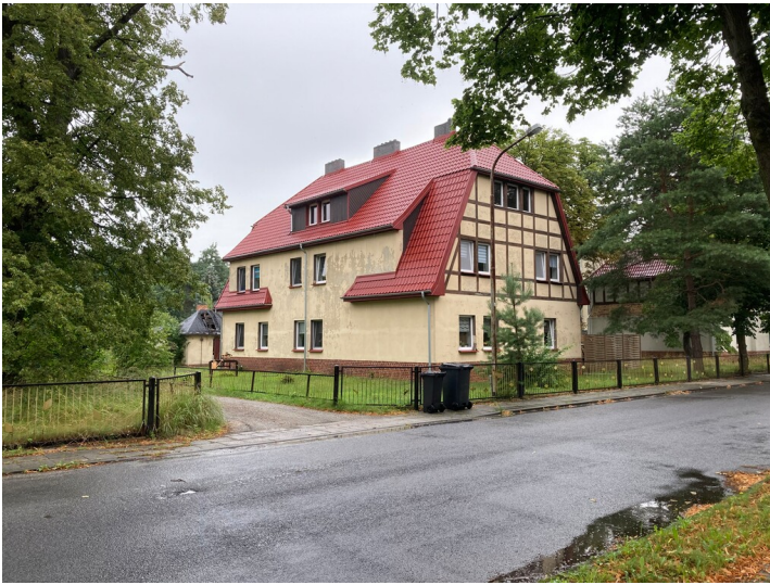
Giebelständiges Mehrfamilienhaus der Werkssiedlung Knappenrode, Lessingstraße 15 Fotograf/Urheber: Nora Wiedemann
