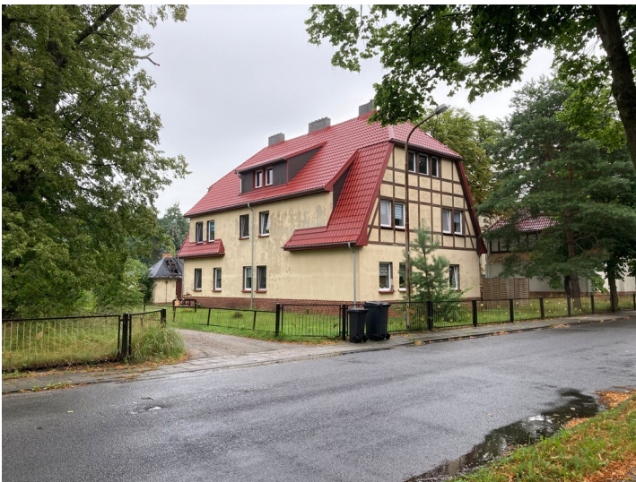
Giebelständiges Mehrfamilienhaus der Werkssiedlung Knappenrode, Lessingstraße 15 Fotograf/Urheber: Nora Wiedemann
