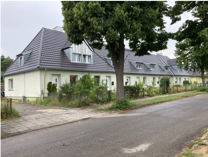
Mehrfamilienhaus der Werkssiedlung Werminghoff in Knappenrode Fotograf/Urheber: Nora Wiedemann
