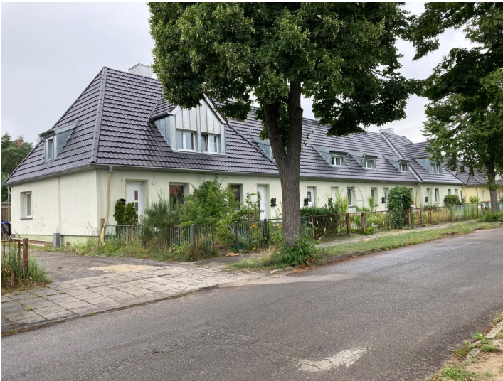
Mehrfamilienhaus der Werksiedlung Werminghoff in Knappenrode Fotograf/Urheber: Nora Wiedemann
