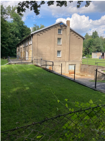
Betriebsgebäude Fotograf/Urheber: Nora Wiedemann
