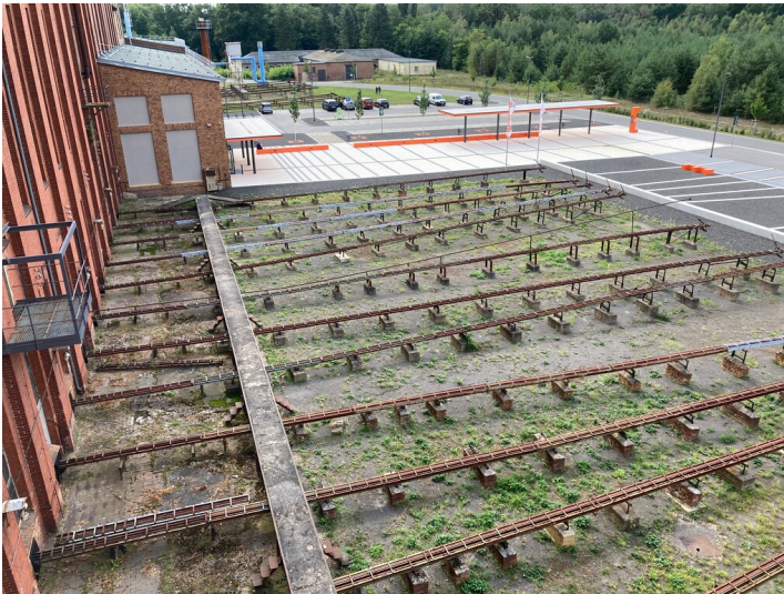
Rinnenhof Fotograf/Urheber: Nora Wiedemann
