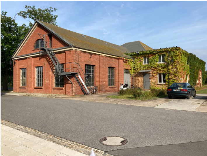
Werkstattgebäude mit Verwaltungsanbau, Ansicht von Süd-Ost Fotograf/Urheber: Nora Wiedemann
