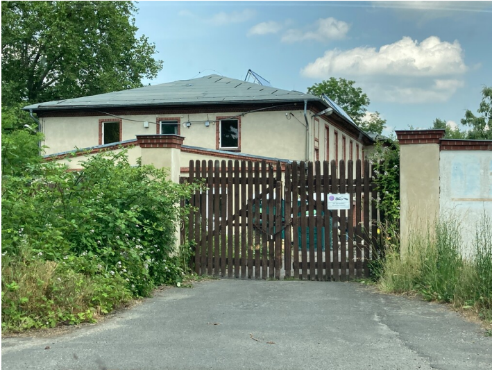
Ehemalige Brikettfabrik Ramsdorf, bestehend aus Brikettierung, Kraftwerk sowie Sozial- und Werkstattgebäude Fotograf/Urheber: Josephine Drefßler
