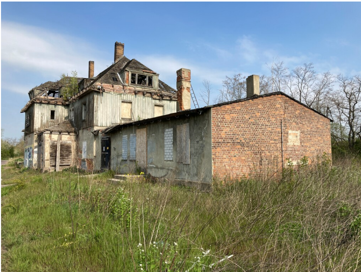
Empfangsgebäude des Personen- und Güterbahnhofs Espenhain Fotograf/Urheber: Cynthia Thomas
