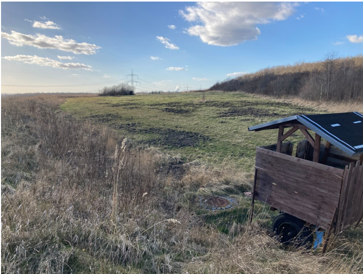
Teil der Objektgruppe Halde Trages (30600141), Ehemalige Aschekippe des Braunkohlenwerks Espenhain Fotograf/Urheber: Cynthia Thomas
