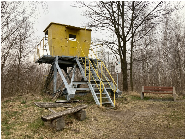
Teil der Objektgruppe Halde Trages (30600141), Fahrerstand Zwischenförderer des Bandabsetzers 1113 Fotograf/Urheber: Josephine Drefßler
