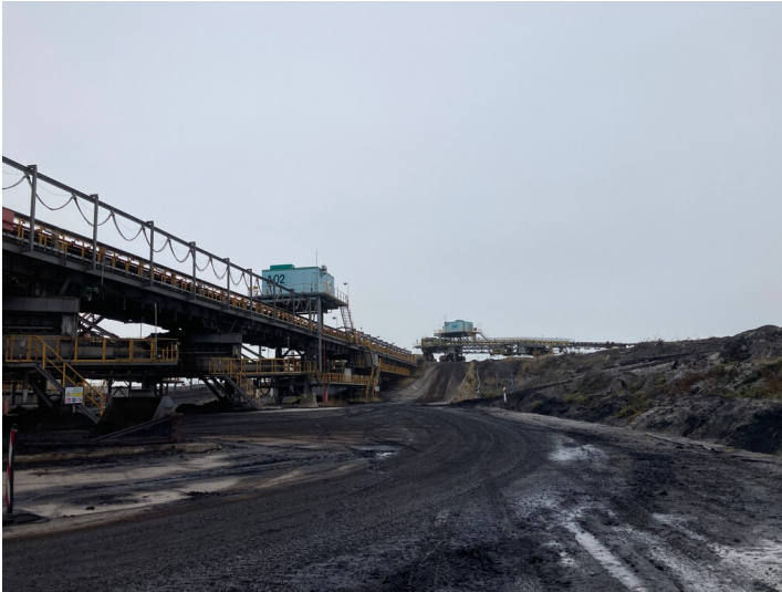
Massenverteiler mit drei Verschiebeköpfe Fotograf/Urheber: Nils Schinker
