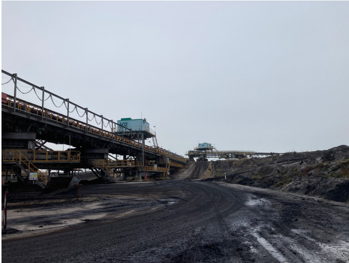
Massenverteiler mit drei Verschiebeköpfe Fotograf/Urheber: Nils Schinker
