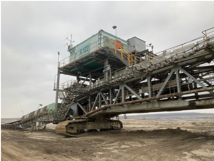
Antriebsstation mit Umlenkstation der Bandanlagen in Strosse 1 Fotograf/Urheber: Nils Schinker
