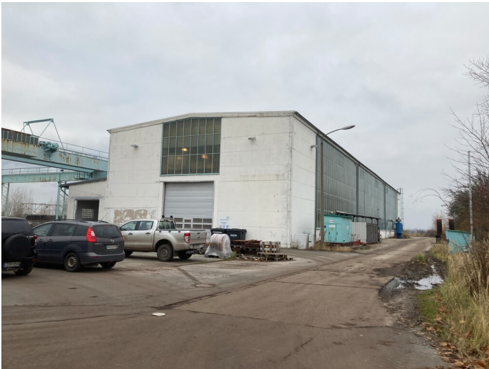
Werkstattgebäude Fotograf/Urheber: Nils Schinker
