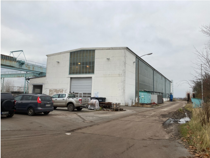
Werkstattgebäude Fotograf/Urheber: Nils Schinker
